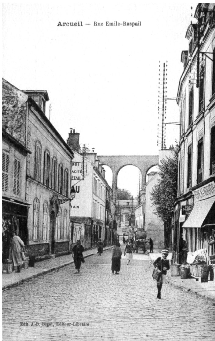
Venski akvadukt, pogled iz ulice koja se ovde često spominje, Emil-Raspaj; ako je suditi po električnoj instalaciji, oko 1910.
