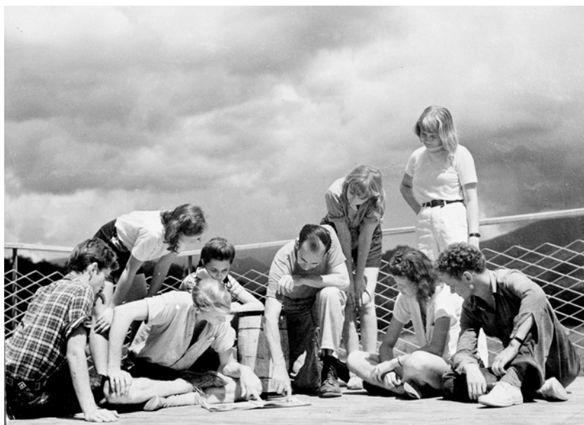
Glavna zgrada koledža, na jezeru Eden, koju su najvećim delom podigli učenici i profesori koledža, prema projektu arhitekta Lorensa Kokera (Lawrence Kocher). Dole: Koker drži čas iz arhitekture, na balkonu koledža, oko 1942.
