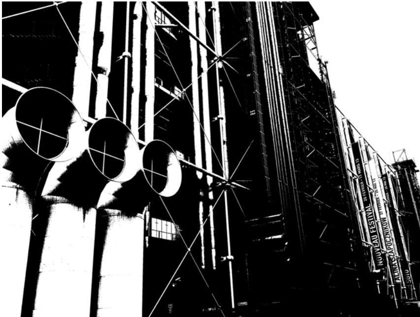
LE CENTRE NATIONAL D'ART ET DE CULTURE GEORGES-POMPIDOU (CNAC; „Centre Georges-Pompidou“, „Centre Pompidou“, „Centre Beaubourg“)
